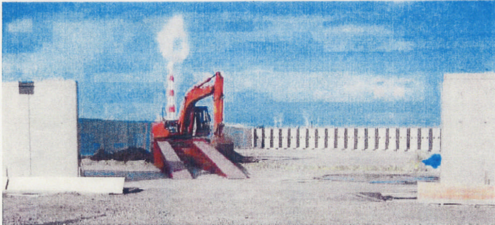
↑ SR工場跡地エリアのバラ品一時保管場(完成直後)
