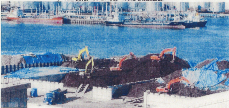
↑ SR工場跡地エリアのバラ品一時保管場(搬入中)
