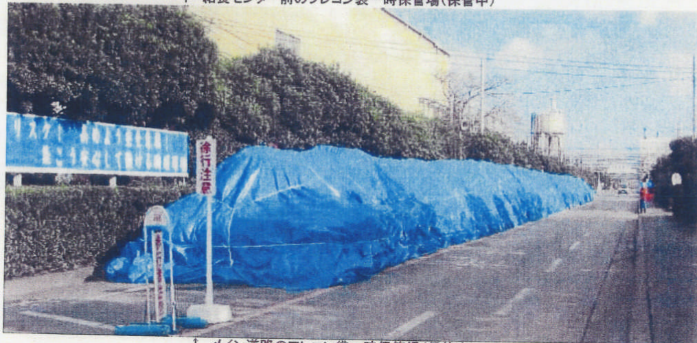
↑ メイン道路のフレコン袋一時保管場(保管中)
